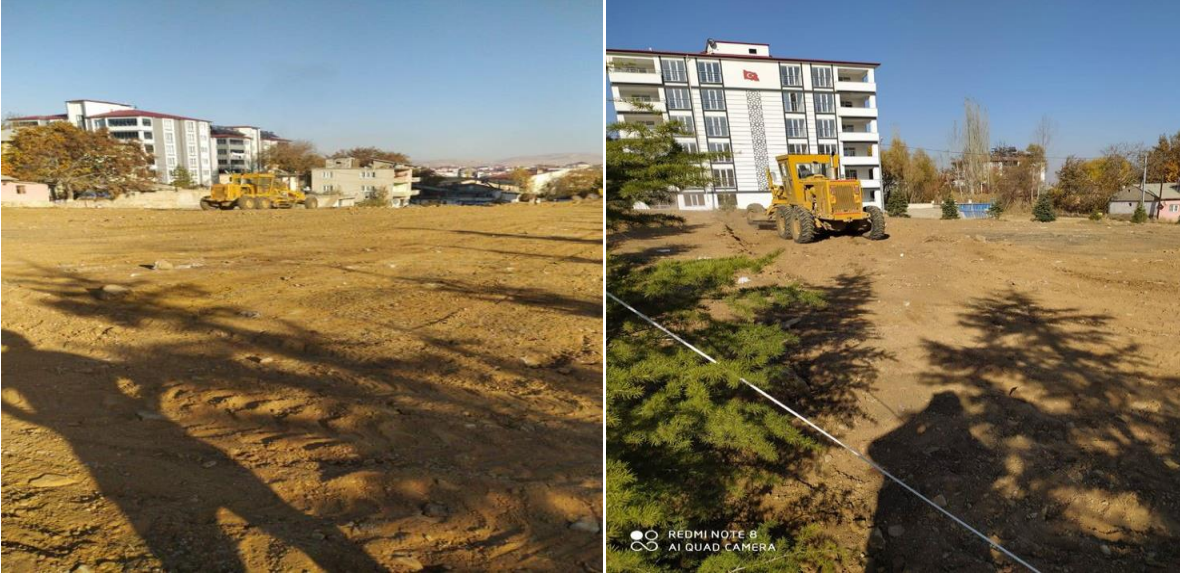
Eski Hayvan Pazarına Park Yapım Çalışmaları
