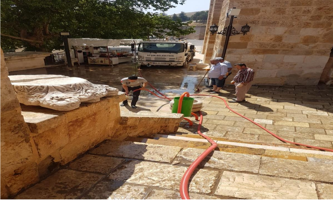
Eshab-ı Kehf Külliyesi Yıkama Çalışmaları
