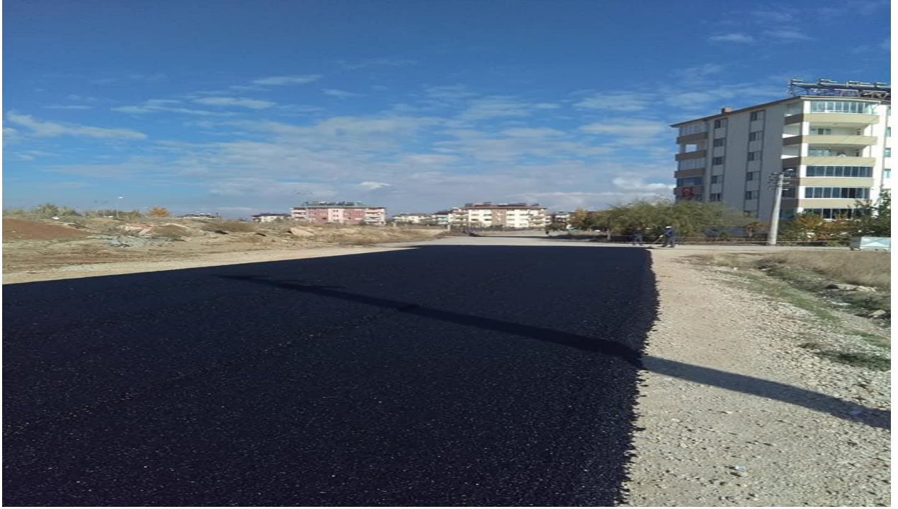
Afşinbey Mahallesi Asfalt Yapımı Çalışmaları
