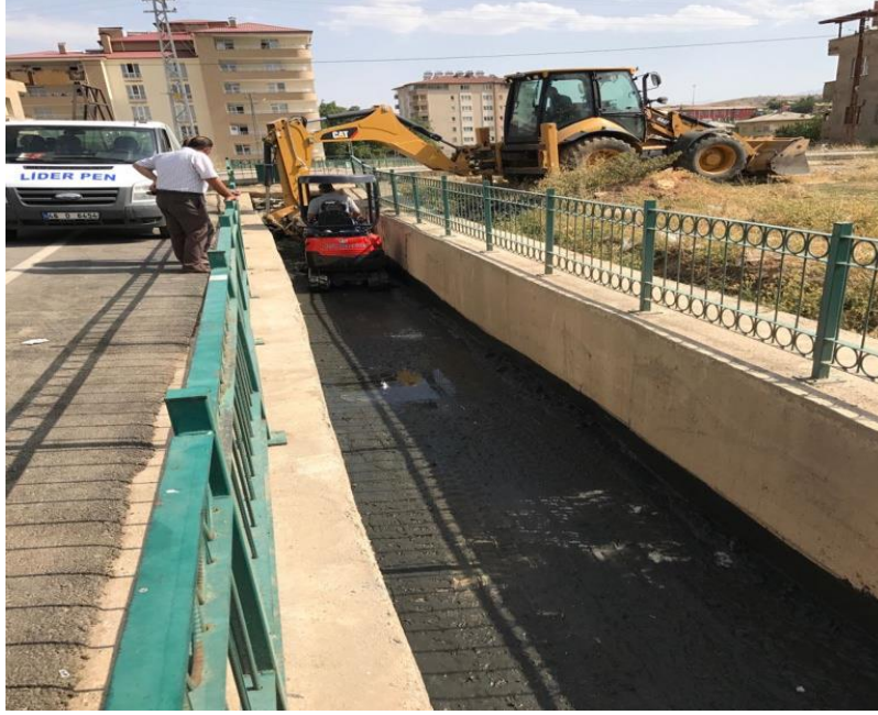
- Pis Su Kanalı Temizleme Faaliyetleri -
