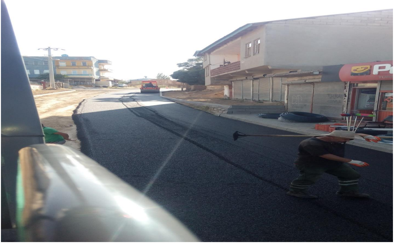
Arıtaş Mahallesi Asfalt Yapımı Çalışmaları
