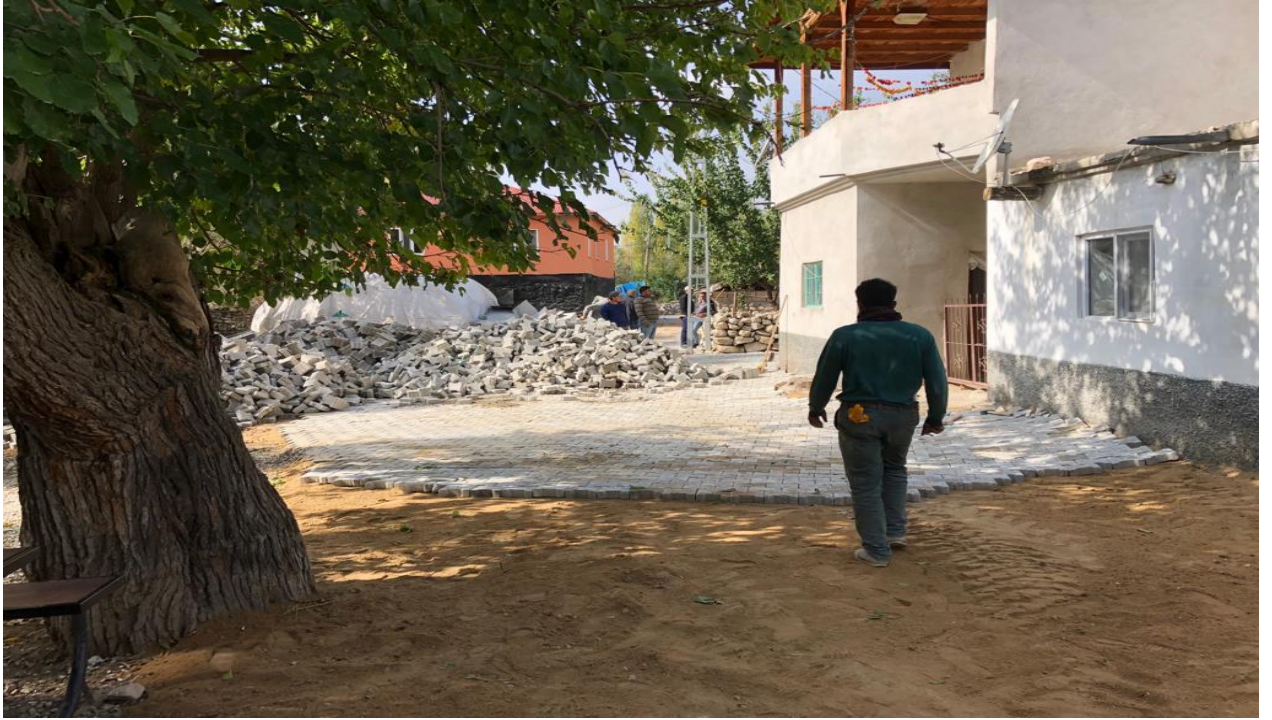
Dokuztay Mahallesi Parke/Bordür Yapımı Çalışmaları
