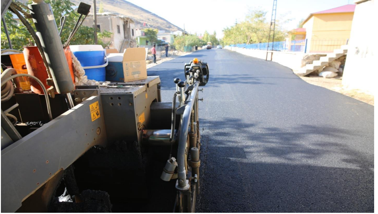
Arıtaş Mahallesi Asfalt Yapımı Çalışmaları
