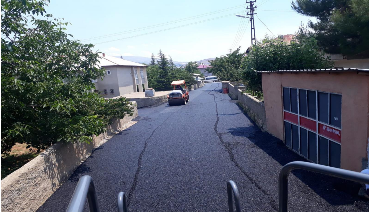
Beyceğiz Mahallesi Asfalt Yapımı Çalışmaları
