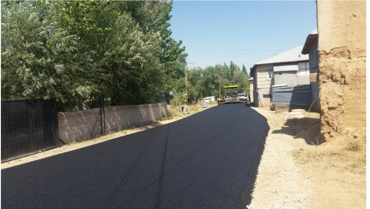
Bakraç Mahallesi Asfalt Yapımı Çalışmaları
