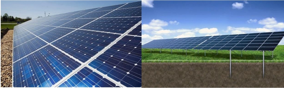
Güneş Enerji Santrali
