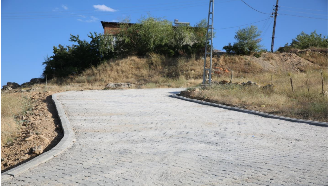
Yazıköyü Mahallesi Parke/Bordür Yapımı Çalışmaları
