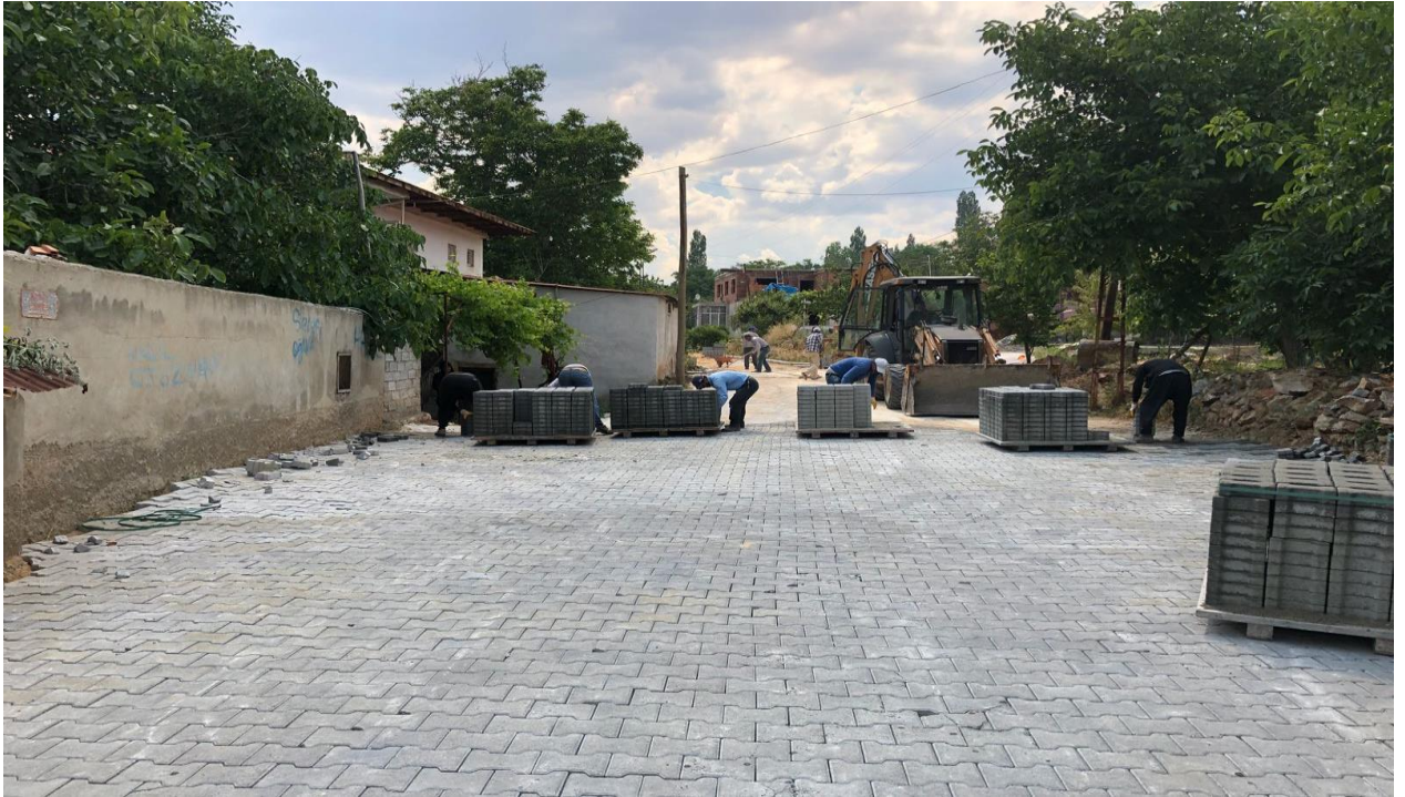
Beyceğiz Mahallesi Parke/Bordür Yapımı Çalışmaları
