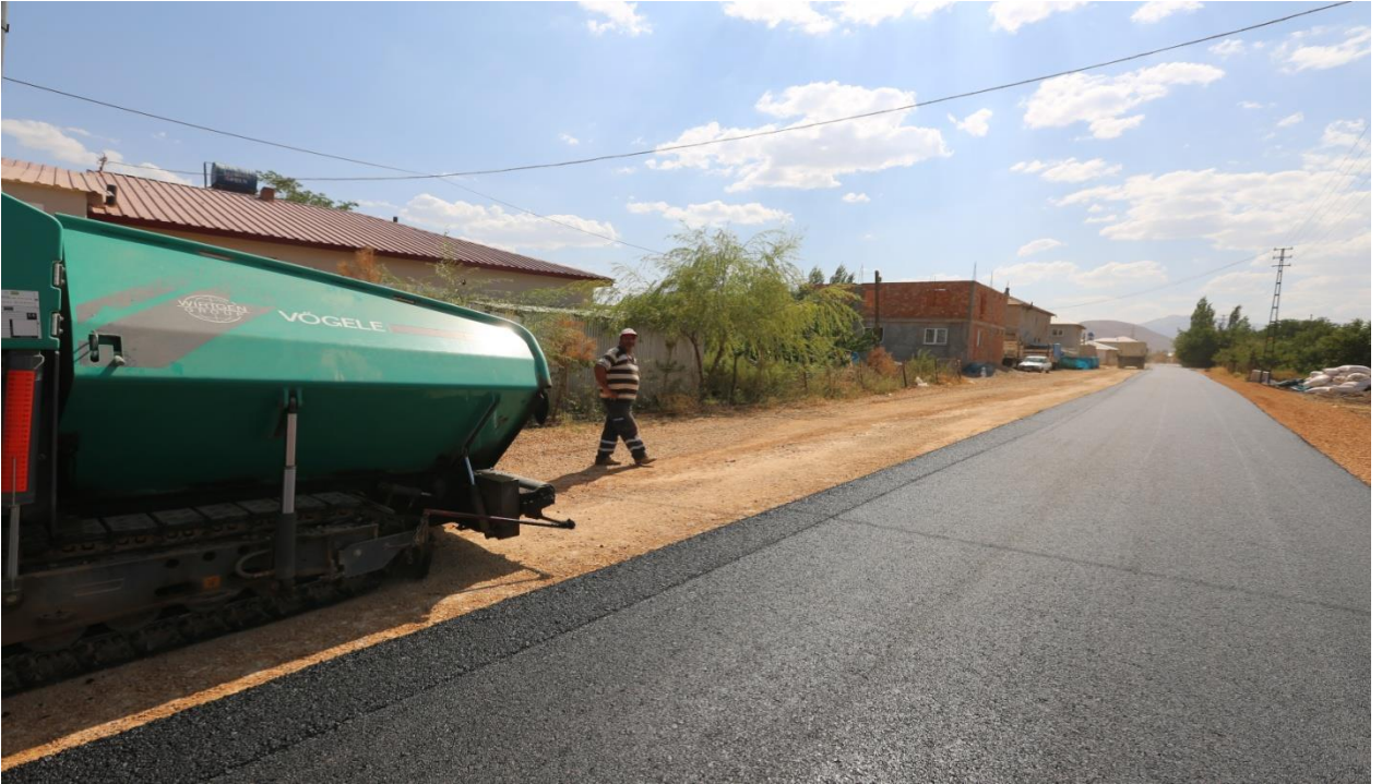
Alpaslan Mahallesi Asfalt Yapımı Çalışmaları
