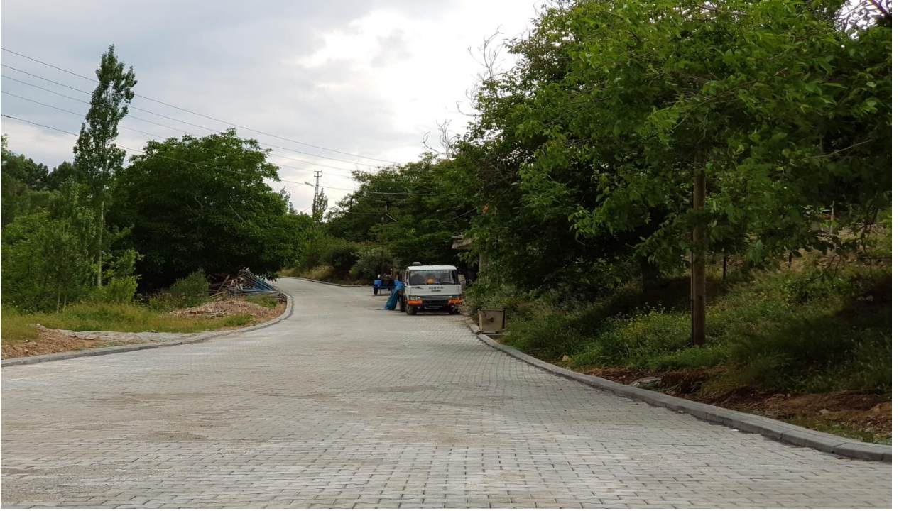
Pınarbaşı Mahallesi Parke/Bordür Yapımı Çalışmaları
