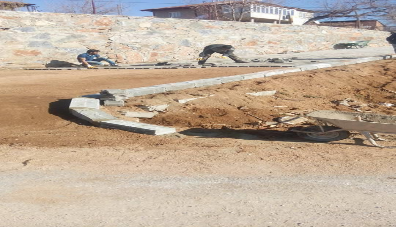
Deveboynu Mahallesi Parke ve bordür döşeme çalışmaları
