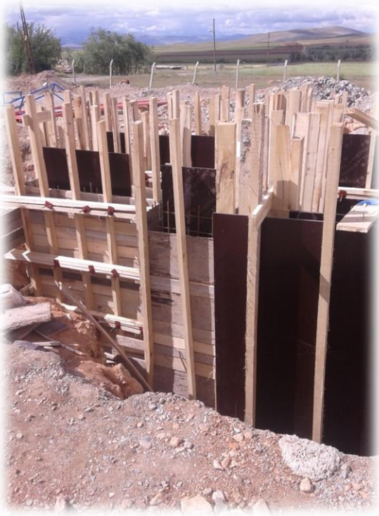
Beton Elamanları Üretim Makinası ve Beton Santrali Temellerinin Yapım Aşamaları
