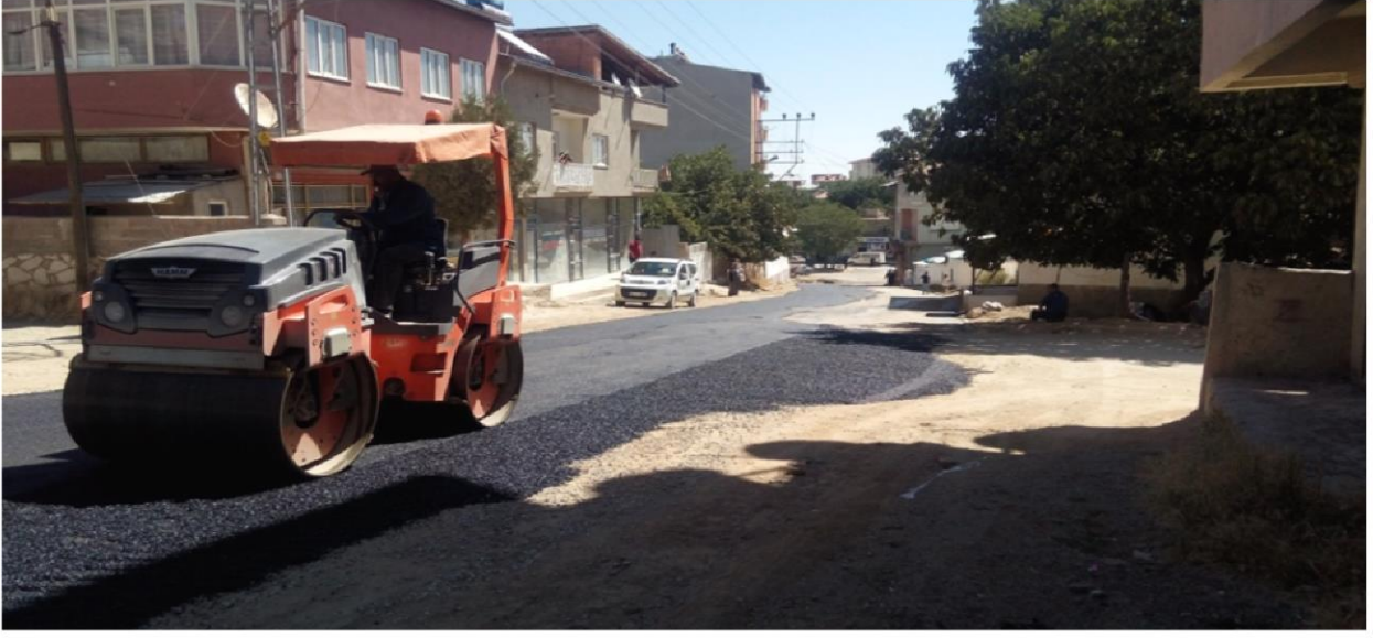
Afşin Merkez Alt Yapı Çalışmasından Dolayı Bozulan Beyceğiz Mahallesi Yapım Çalışması
