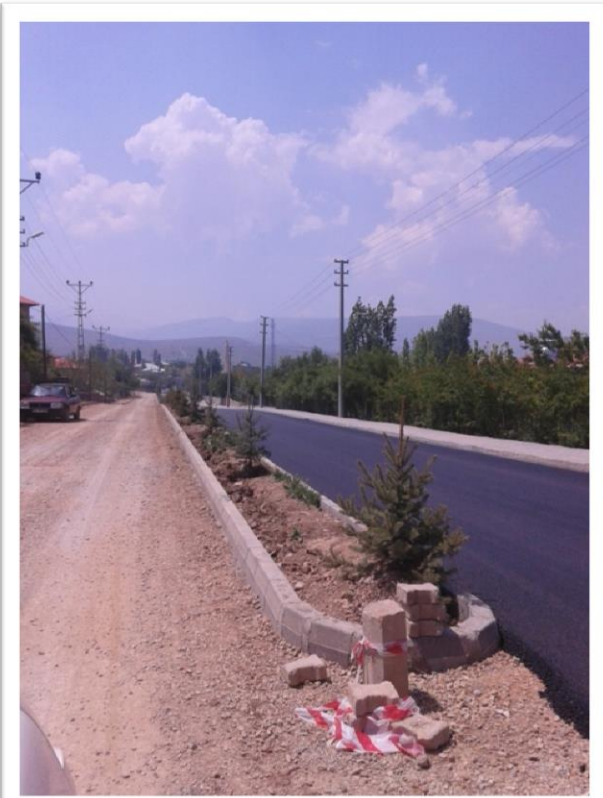
Altunelma Mahallesi Ana Yolu ve Çarşısının Kilit Parke ve Asfalt Kaplama Yol Çalışmaları
