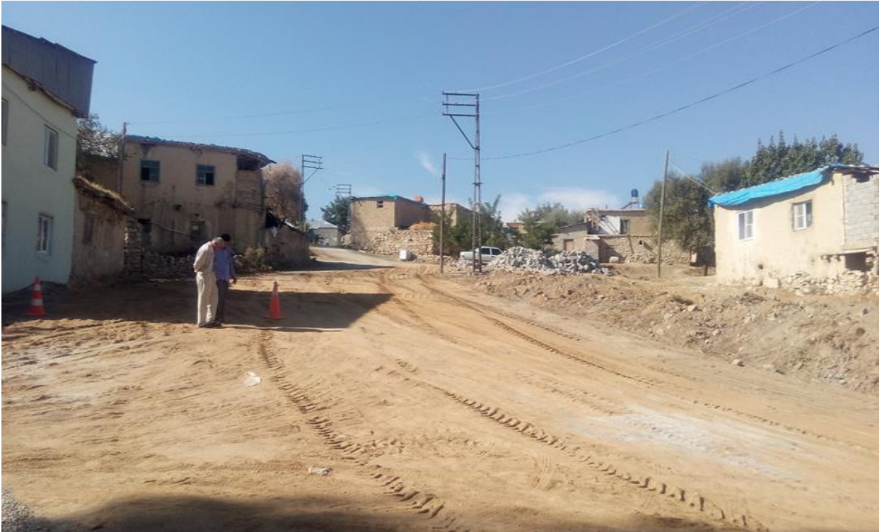
Nadir Mahallesi Bordür döşeme çalışmaları
