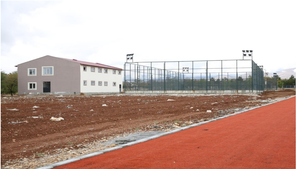
Soyunma Odaları ve Tenis Kortu Yapım Çalışmaları
