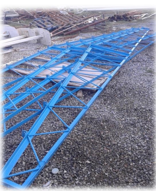
Atıl Vaziyette Bulunan Makasların Bakımı Yapılarak Beton Elemanları Üretim Makinası Üzeri Kapatılması
