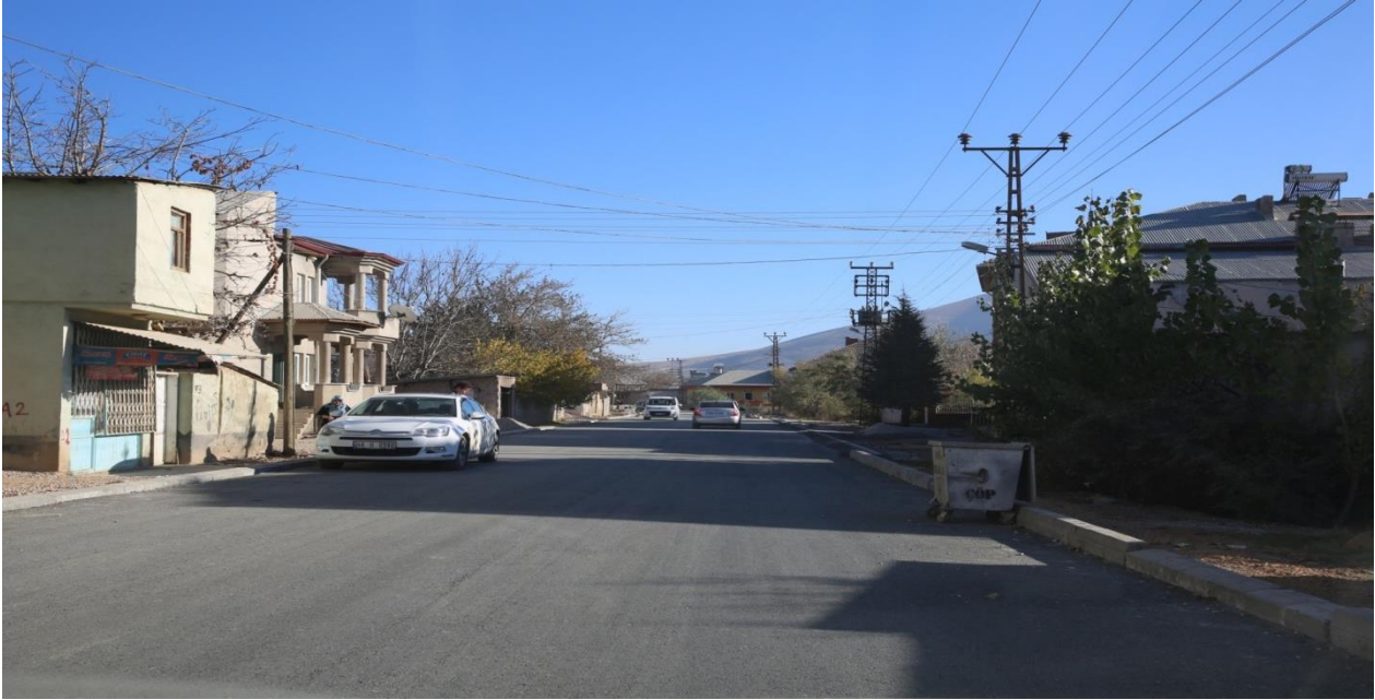
Alt Yapısı biten Karşıyaka yolu 1988 metre uzunluğunda 8 metre eninde sıcak asfalt kaplama yol çalışması yapımı
