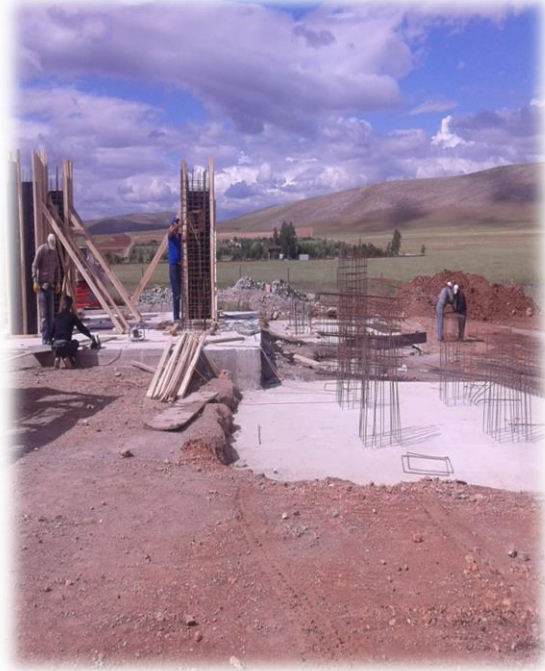
Beton Elamanları Üretim Makinası ve Beton Santrali Temellerinin Yapım Aşamaları
