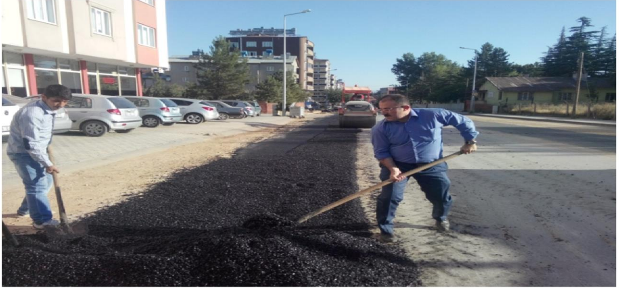
Alt Yapı Çalışmasından Dolayı Bozulan Nazım Kaynak Bulvarı Yapım Çalışması
