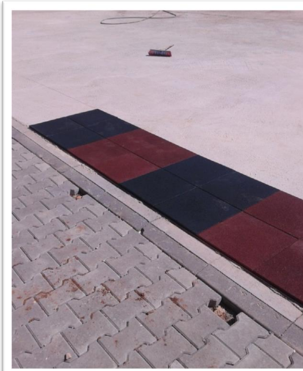
Oyun Grubu Zeminin Kauçuk Kaplama Çalışması
