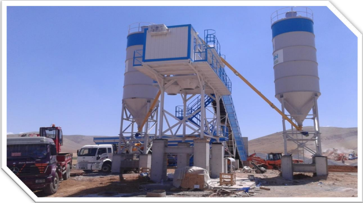
Beton Elamanları Üretim Makinası ve Beton Santrali Temellerinin Yapım Aşamaları
