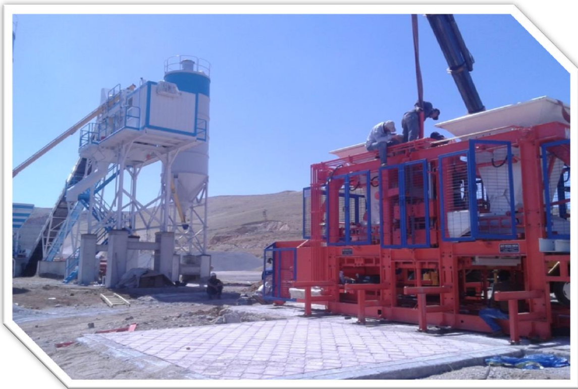
Beton Elamanları Üretim Makinası ve Beton Santrali Temellerinin Yapım Aşamaları
