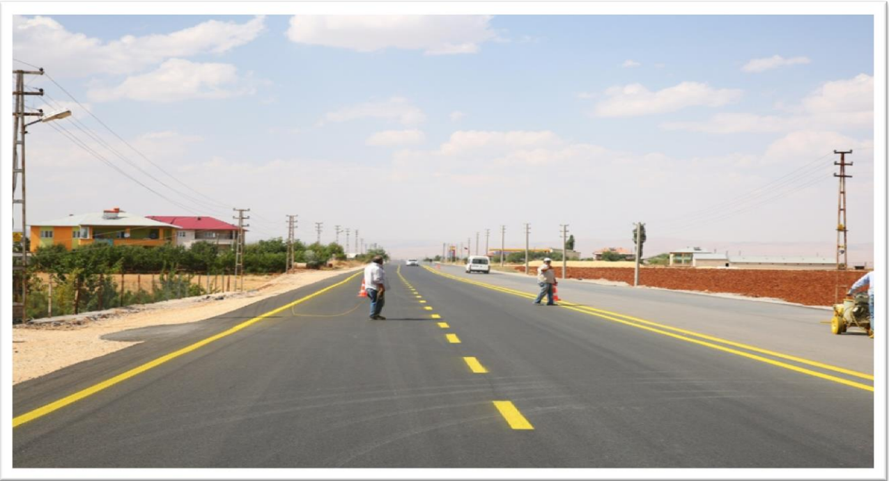
Alpaslan Mahallesi İle Gaziosmanpaşa Mahallemizi bölen ve Kuzey Mahallelerimizin Yoğun Olarak Kuzey Yolunun Sıcak Asfalt Kaplama Çalışmaları
