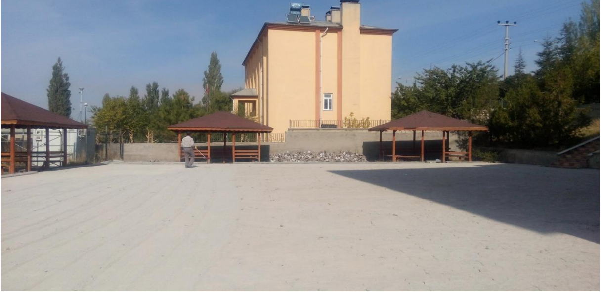
Alemdar Mahallesi Okul Bahçesi parke ve bordür çalışması
