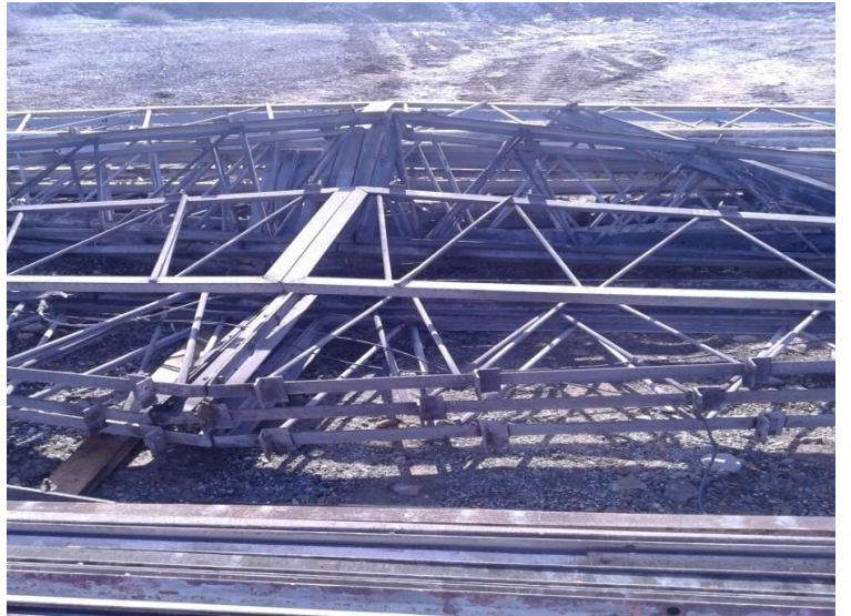
Atıl Vaziyette Bulunan Makasların Bakımı Yapılarak Beton Elemanları Üretim Makinası Üzeri Kapatılması
