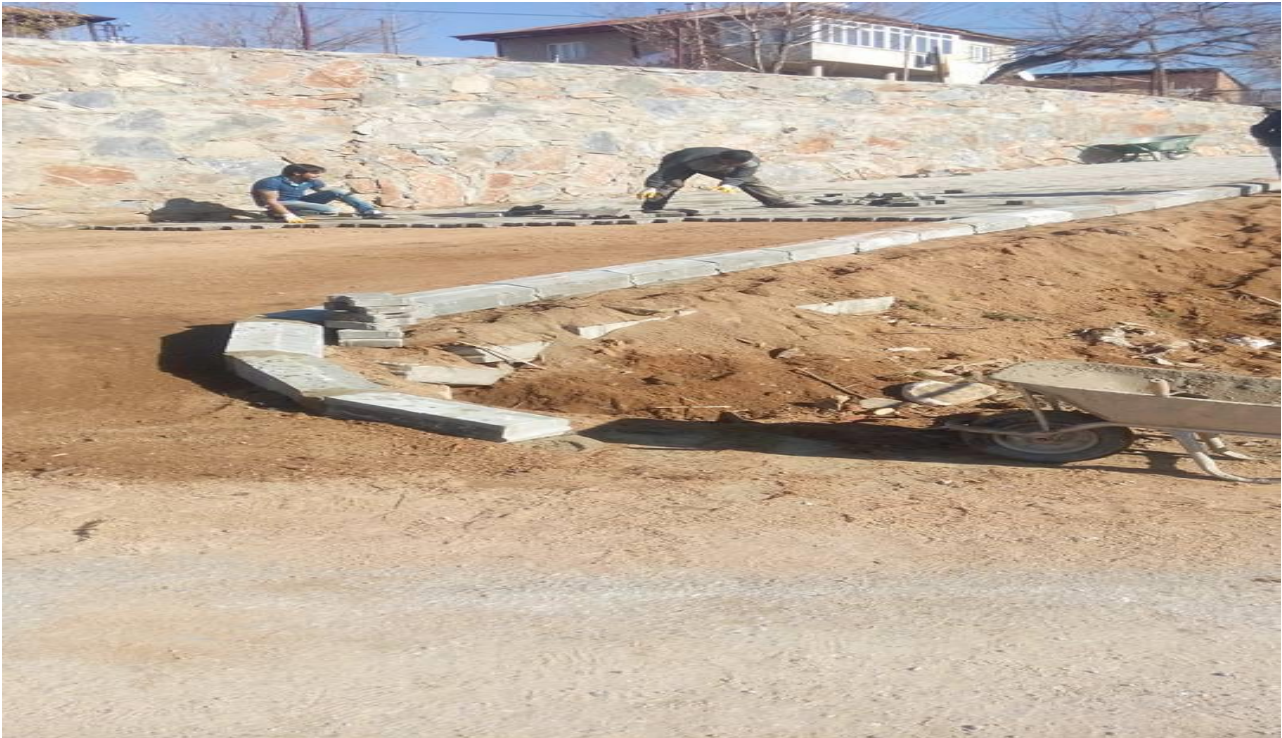
Deveboynu Mahallesi Parke ve bordür döşeme çalışmaları.
