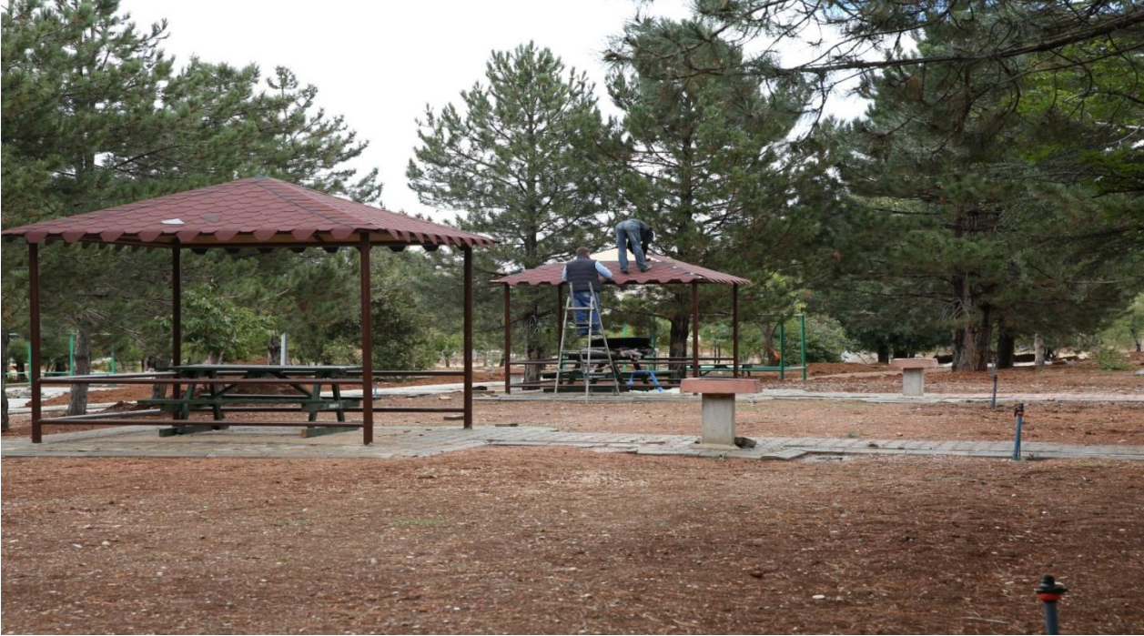
Rabia parkı ikinci etap için 23 adet kamelya imal edildi. Kamelyaların çatıları şingil kaplandı.
