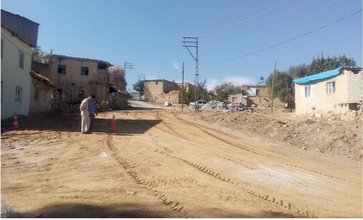
Nadır Mahallesi Bordür döşeme çalışmaları
