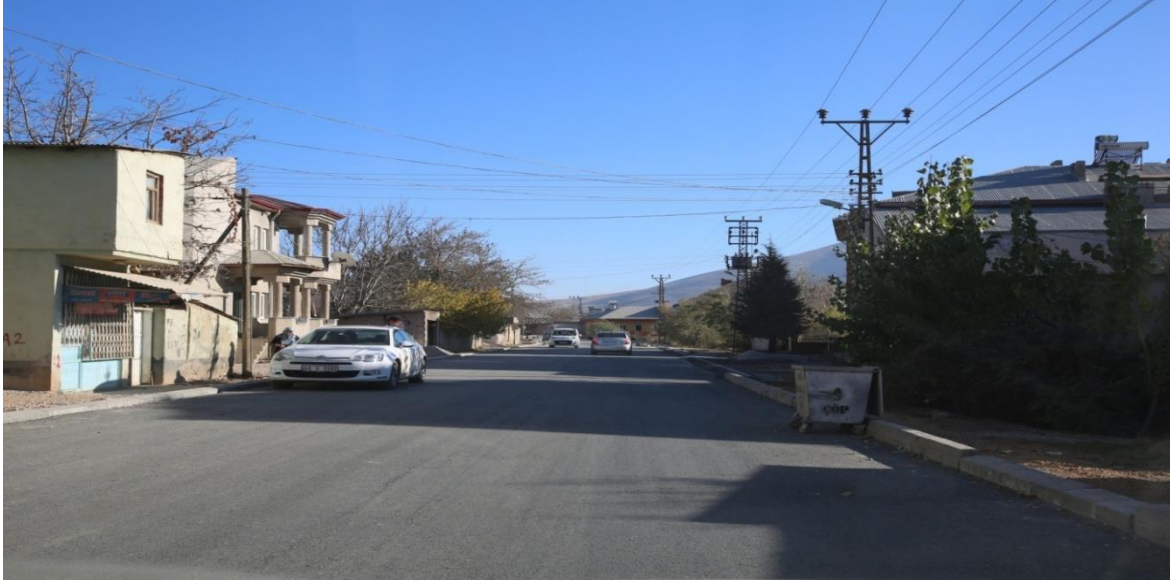
Karşıyaka Mahallesi asfalt çalışması
