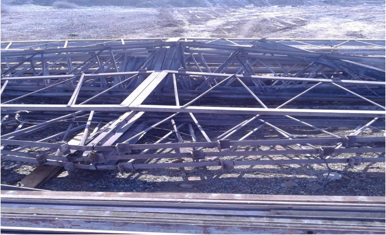
Atıl vaziyetteki makaslara bakım yapılarak beton elemanları üretim makinası üzeri kapatıldı
