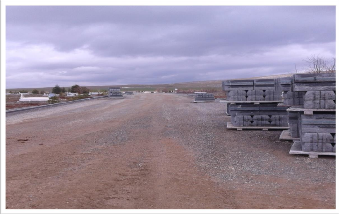
Asri Mezarlık parke ve bordür yapım çalışmaları.
