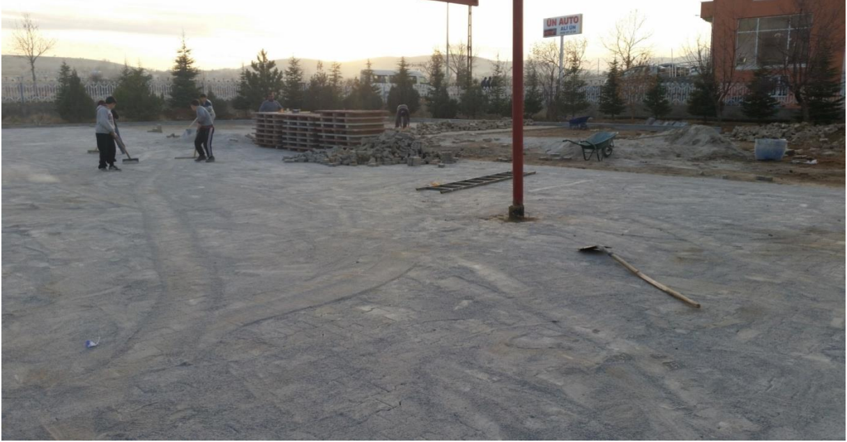
Kuran Kursu Bahçesi parke ve bordür döşeme çalışması
