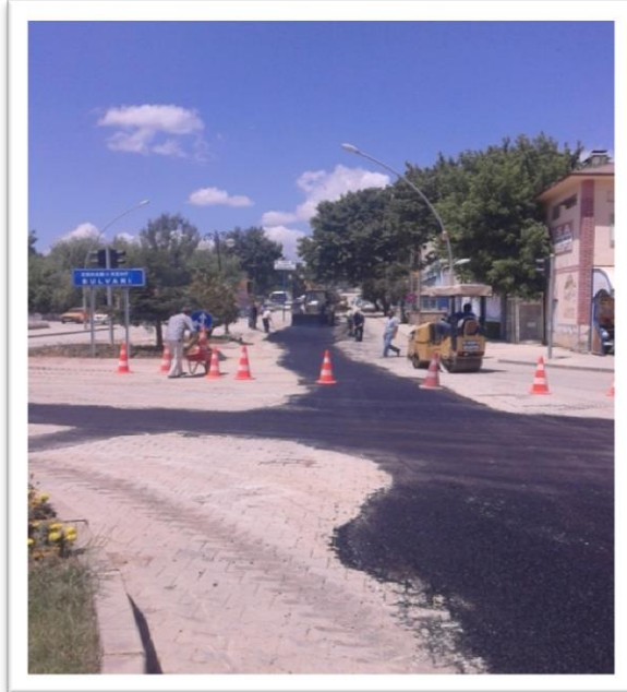
Afşin merkez asfalt çalışmaları.
