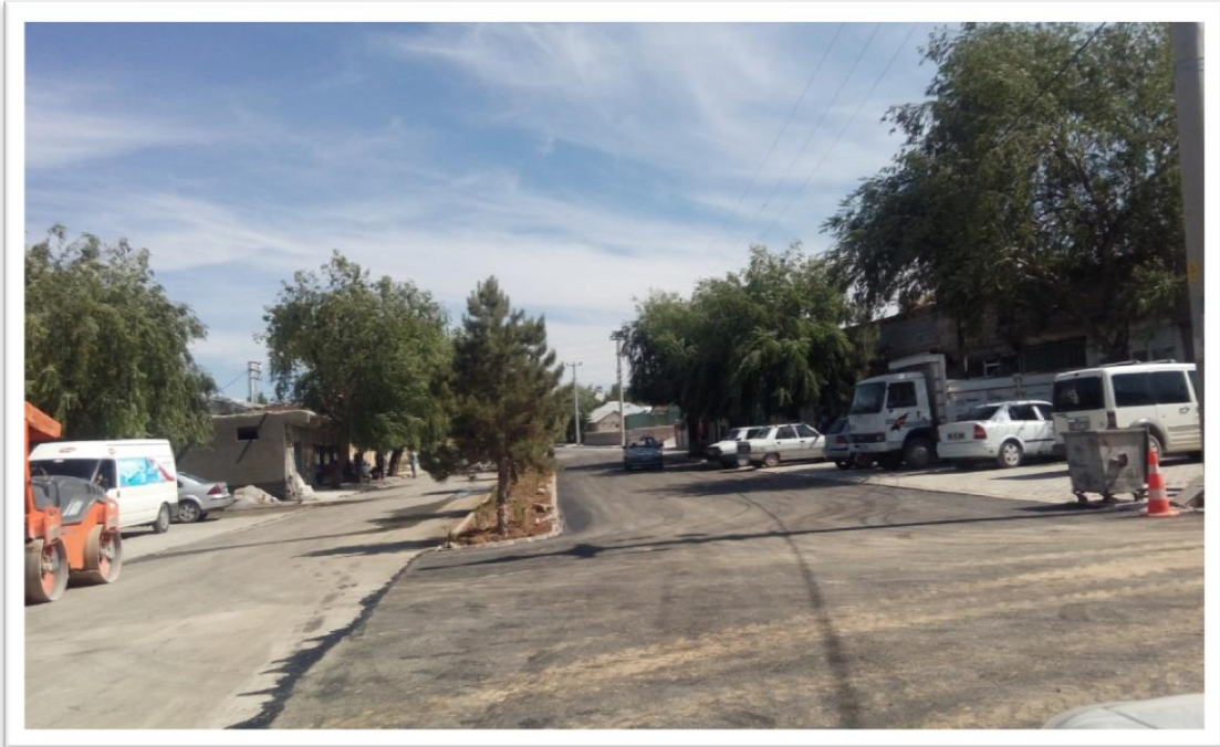
Altunelma Mahallesi asfalt çalışması
