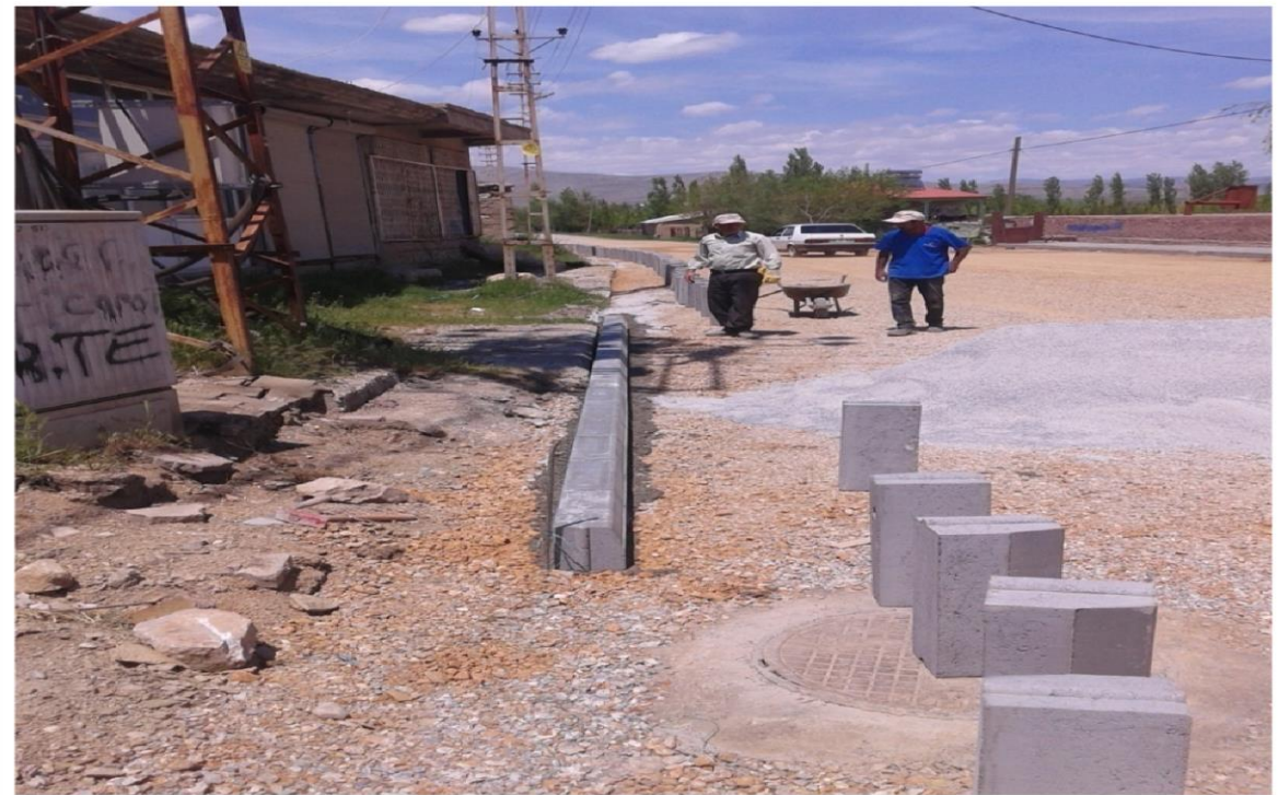
Altunelma Mahallesi merkez parke ve bordür döşeme çalışmaları
