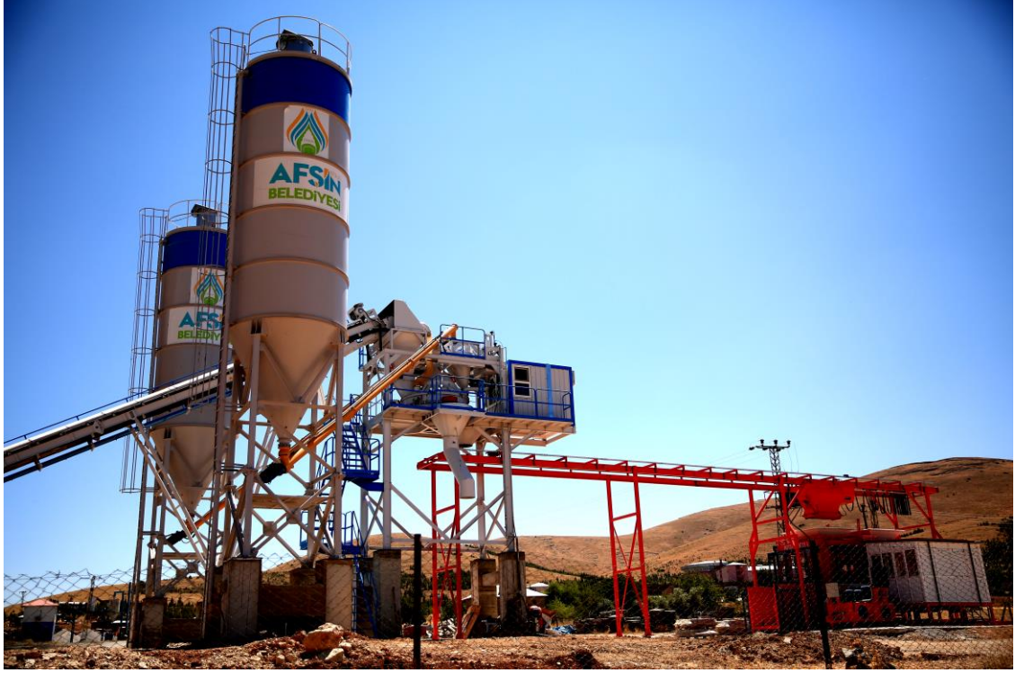
-Afşin'e Kazandırdığımız Beton Elemanları Üretim Tesisi-
